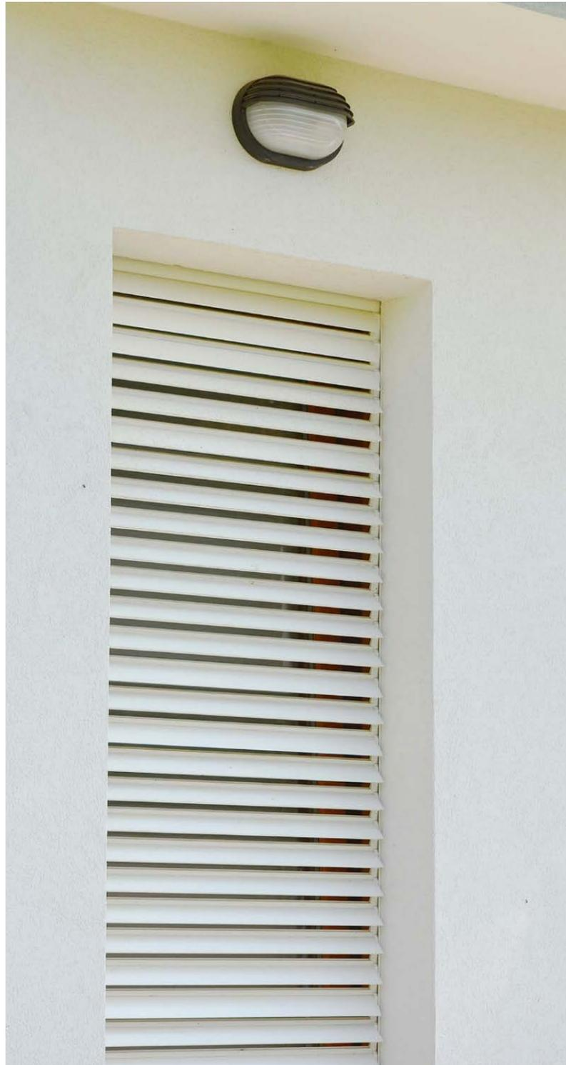
La tapparella in alluminio (tipo Roll Flap) sfrutta il proprio peso per far orientare le alette ed è possibile decidere quante alette aprire. Questo sistema aiuta il ricircolo dell'aria senza dover lasciare aperto il passaggio, ma soprattutto lascia entrare molta luce interna non diretta. Il sistema è applicato su classico cassonetto in legno o cassonetto coibentato.
